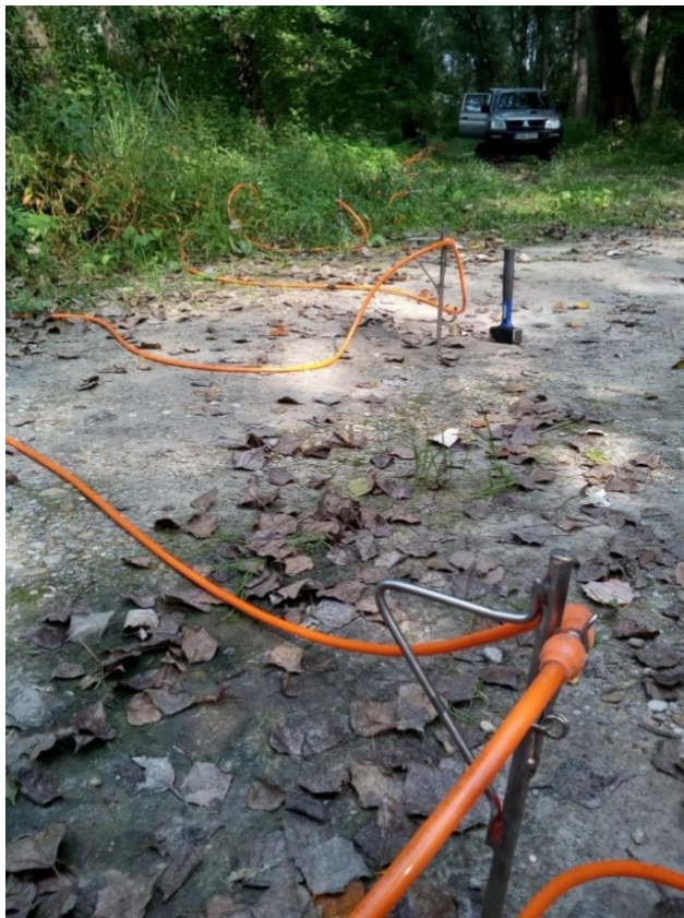
5. ábra: Sokelektrodás mérés: terítés (elektrodák és a mérőkábel)
