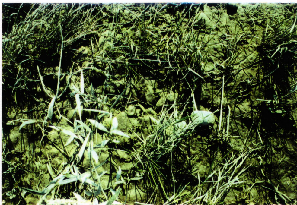
A hordalékos árhullámok és a mederbe települt vegetáció folyamatosan iszapolják (kolmatálják) a kavicsos szűrőréteget.
