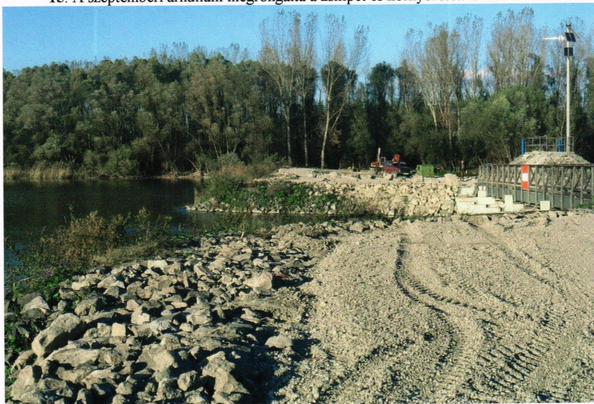
16. A helyreállítás során a felvízi partot kőszórással erősítették meg. Október 29.
