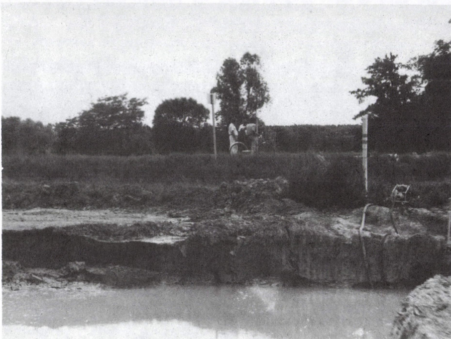
4. kép. Hédervári építkezésen feltárt vékony fedőrétegű övzátányok szelvénye. (A finomfrakció kitöltése 0,5–1,2 m.)
