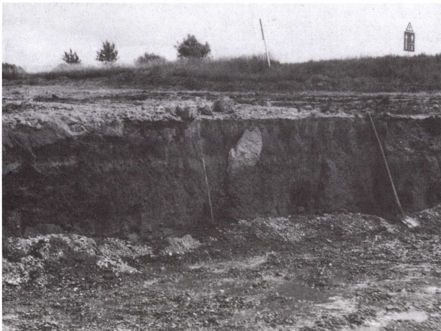
3. kép. Hédervári építkezésen feltárt vékony fedőrétegű övzátányok szelvénye. (A finomfrakció kitöltése 0,5–1,2 m.)
