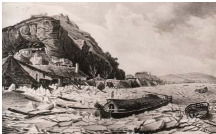
2. kép. Hátborzongató rajz az 1838. évi dunai áradásról: összetorlódott jégtáblák a Gellérthegy lábánál
