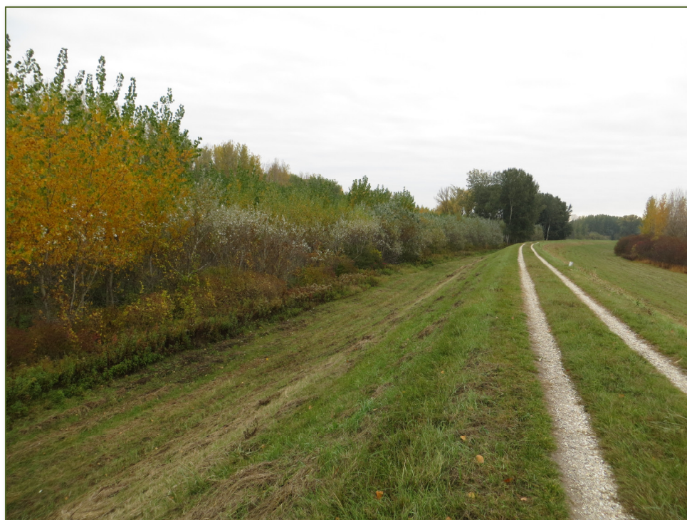
13. ábra: A töltéseket többnyire másodlagos, jellegtelen gyepek boríták
