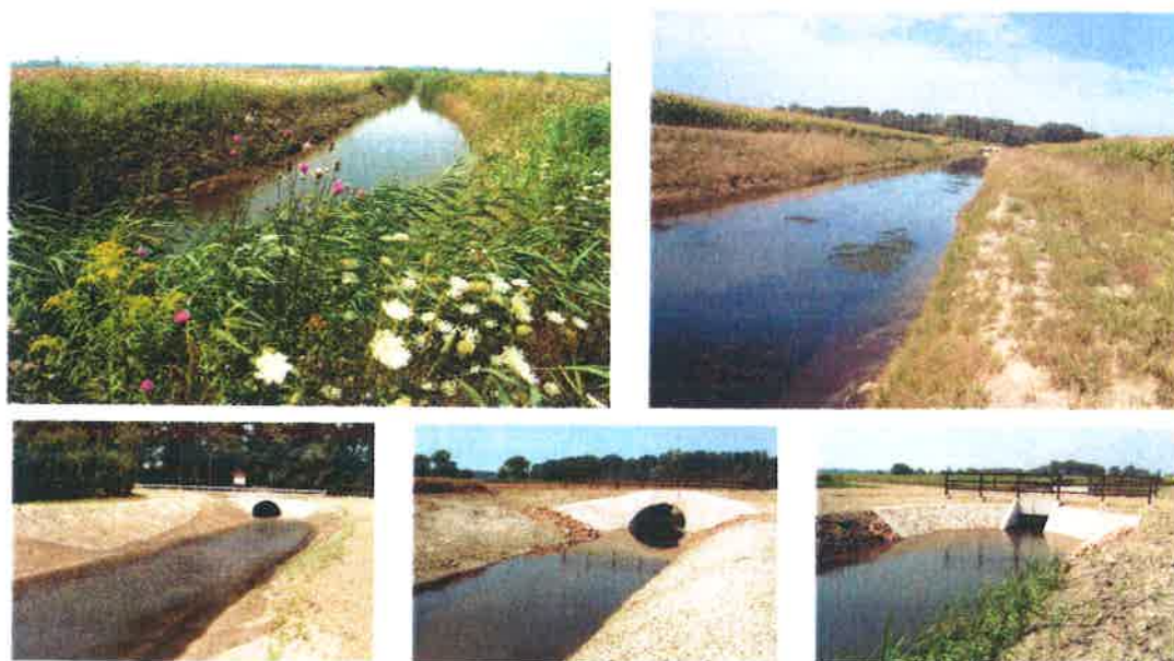
Parlagnyilasi csatorna (a,b) és műtárgyai (c,d,e)
