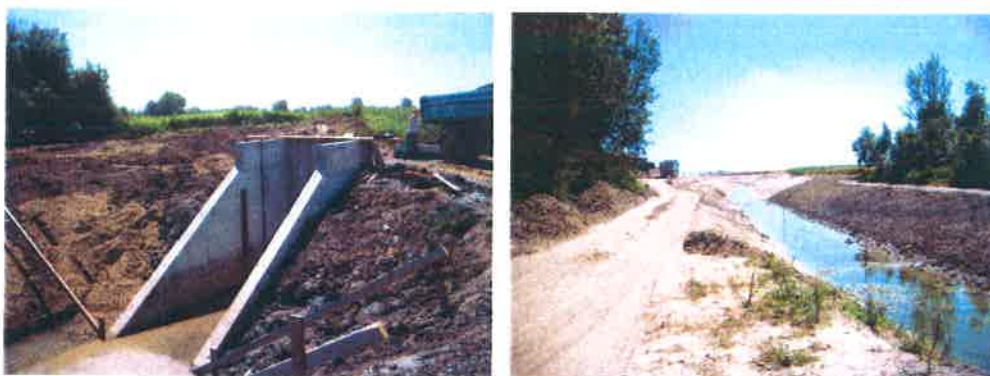
Parlagnyilasi csatorna építése
