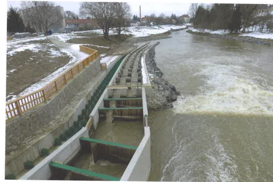
Rába Szentgotthárd. Halátjáró kefelemes csónakcsúszdával
