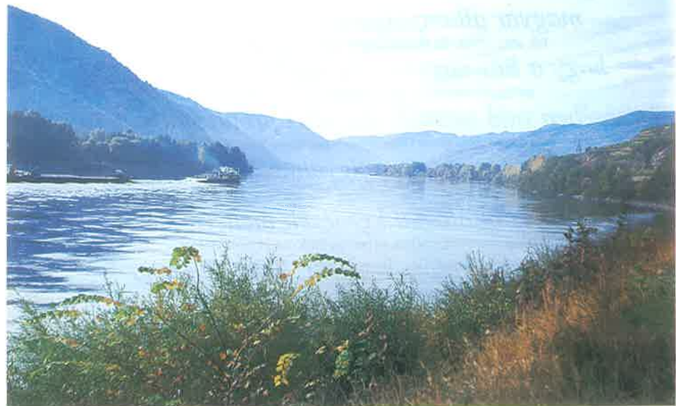
A: Ausztriai Wachau-ban tervezett, de meg nem épített Rührsdorf-i erömu helye Blick auf den Standort des früher geplanten Kraftwerks Rührsdorf (Wachau)
