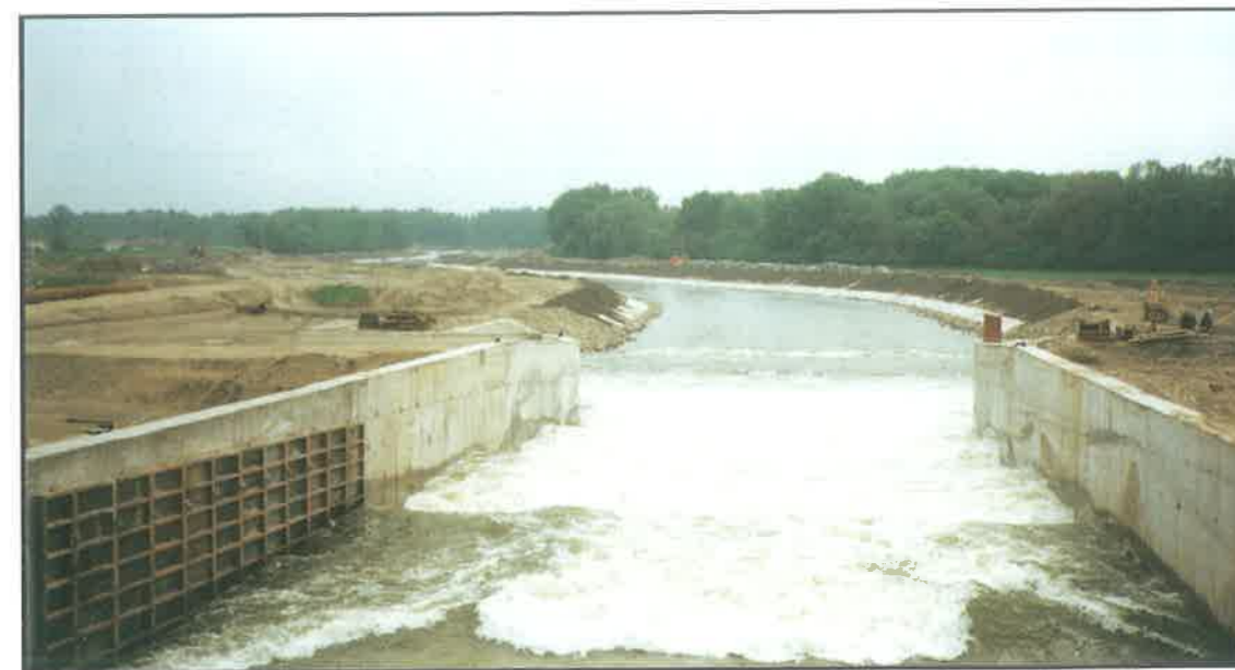
19. A folyóágrendszer feltöltésére szolgáló vízátvezető berendezés Dobrohošť mellett. A felvétel az 1993 májusában végzett vízpótlás kezdeti szakaszában készült
