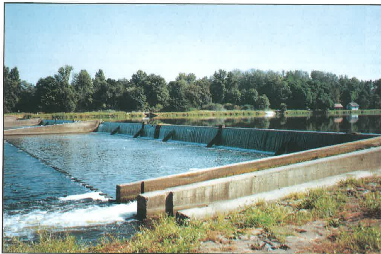
16. A Rhinau melletti rajnai vízierőmű eredeti medrében megépített keresztirányú duzzasztóküszöb és hallépcső látképe
