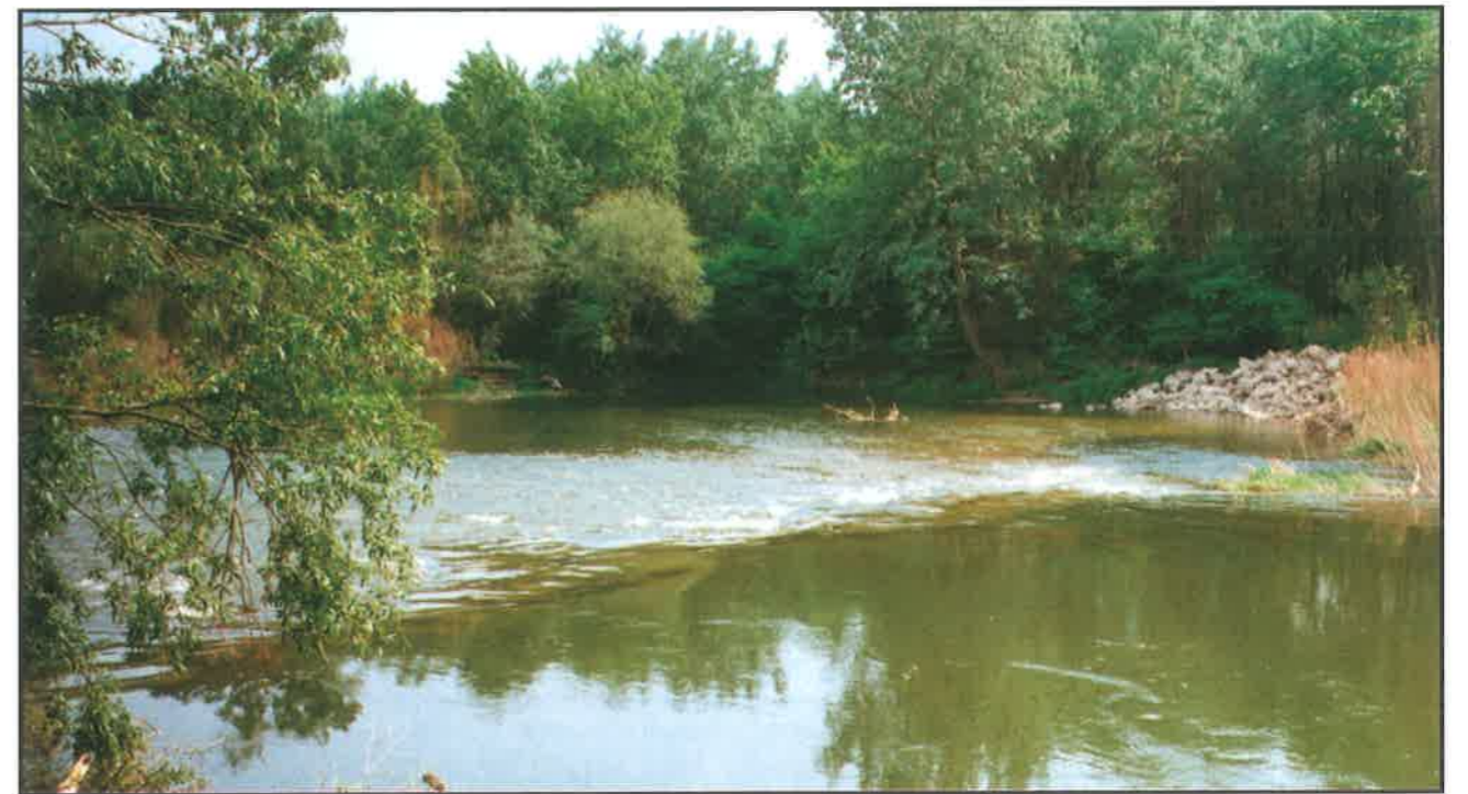
7. Kőből épült keresztirányú műtárgy a Dobrohošť melletti folyóágban. A fűvel benőtt mederfenék azt bizonyítja, hogy az ág már jóval a Duna elrekesztése előtt rendszeresen kiszáradt
