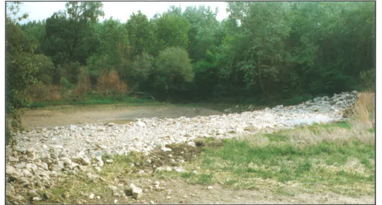
7. Kőből épült keresztirányú műtárgy a Dobrohošť melletti folyóágban. A fűvel benőtt mederfenék azt bizonyítja, hogy az ág már jóval a Duna elrekesztése előtt rendszeresen kiszáradt
